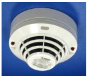
Рис. 24. Искробезопасный тепловой максимально-дифференциальный извещатель 5451EIS
